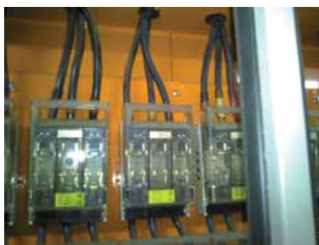
Проверка электрической проводки рядом с предохранителями, покрытыми оргстеклом, выявляет наличие отклонений от нормы. MeterLink позволяет вывести показания, полученные при помощи токоизмерительных клещей, на тепловизионном изображении.
